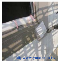
角隅不織布補強，防止裂縫滲水
