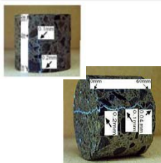
裂縫鑽心取樣
