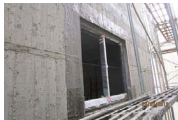
窗框結構體第一道防水
