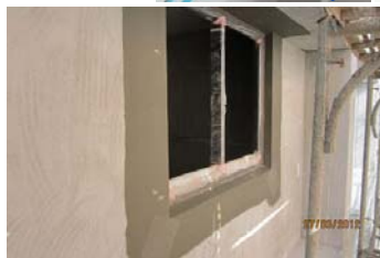
窗框結構體第二道防水
